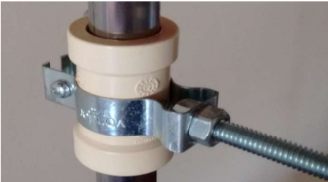
Figura 14: Detalhes da braçadeira e a luva.
